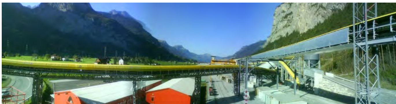
Chantier du tunnel du Saint-Gothard, Erstfeld
